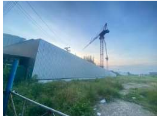
รูปที่ 1 ติดตั้งรั้ว Metal Sheet ความสูง 6 เมตร โดยรอบแนวเขตที่ดิน
