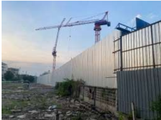
รูปที่ 1 ติดตั้งรั้ว Metal Sheet ความสูง 6 เมตร โดยรอบแนวเขตที่ดิน
