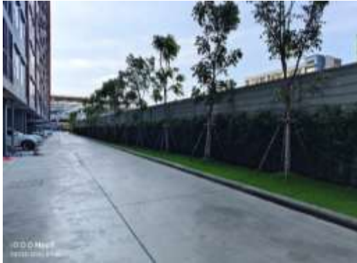
รูปที่ 1 ติดตั้งรั้ว Metal Sheet ความสูง 6 เมตร โดยรอบแนวเขตที่ดิน
