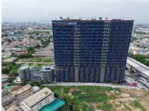
รูปที่ 6 ติดตั้งผ้าใบก่อสร้าง (Mesh sheet) ตลอดความสูงอาคาร
